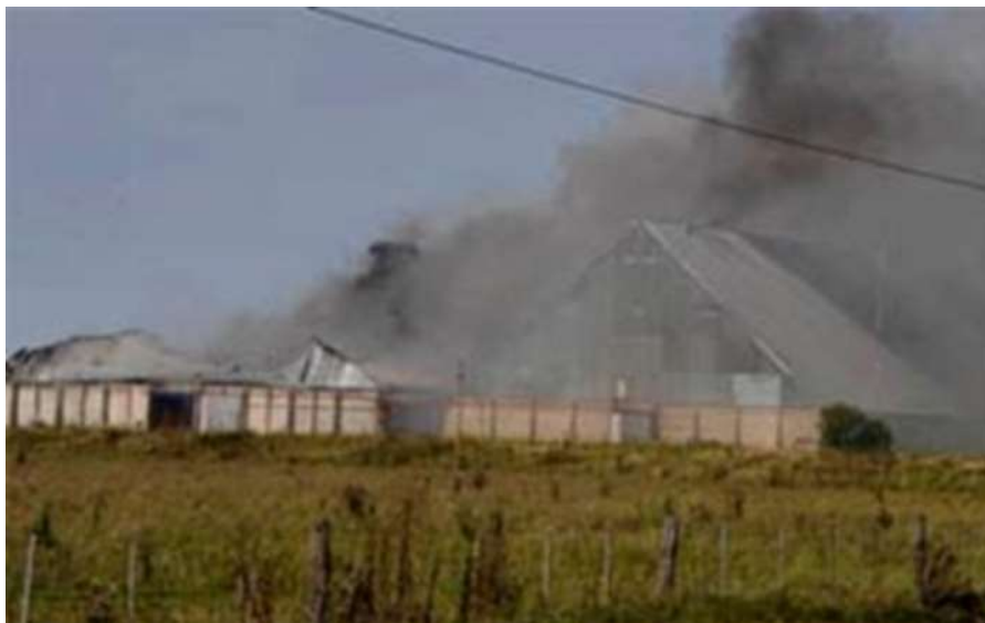
Combustión espontánea en el interior de celdas que contienen semillas de girasol
