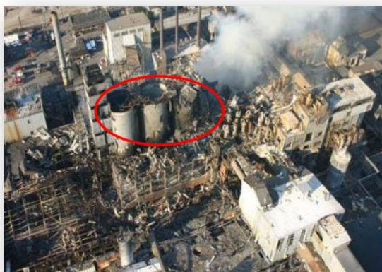
The Imperial Sugar Factory después de una explosión de polvo combustible en 2008.
