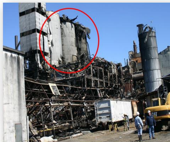
The Imperial Sugar Factory después de una explosión de polvo combustible en 2008.
